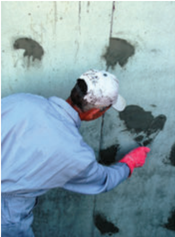
Temel - perde yalıtımlarında yüzey hazırlığı
