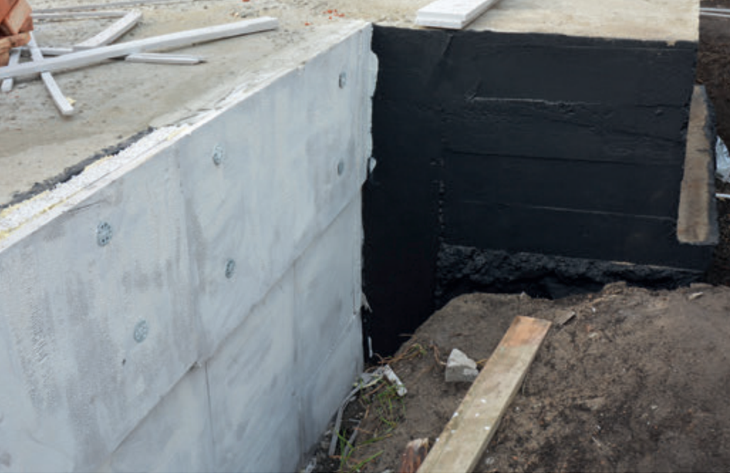
Perde duvarda su yalıtımı
