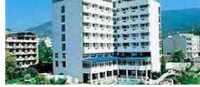
Kuşadası Green Park Hotel Projesi - Aydın
