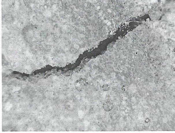
Görsel 2-Aquafix uygulanmamış beton giriş (0,5 mm çatlak oluşturulması)
